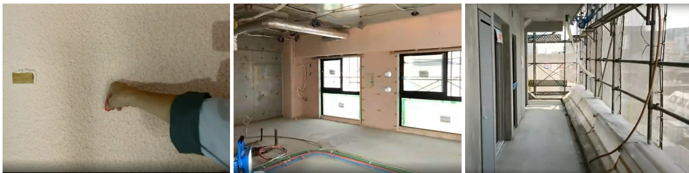
(写真左：断熱材の厚さを測るピンを刺す様子、中央：壁のないスケルトン状態の一室、右：工事中の廊下)
